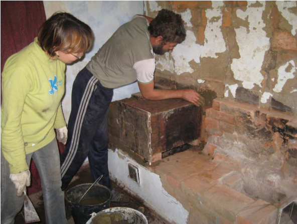
Der alte Ofen wird neu gesetzt...
