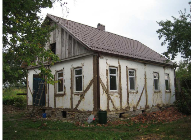
und anfangs September mit neuem Dach, Fenstern und Türen
